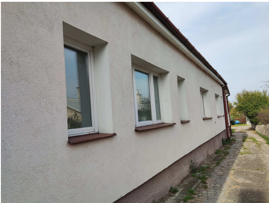
Okna do wymiany w starszej części budynku
